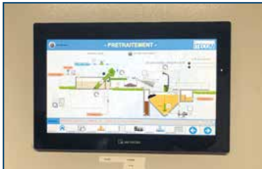
Nouvelle armoire électrique
