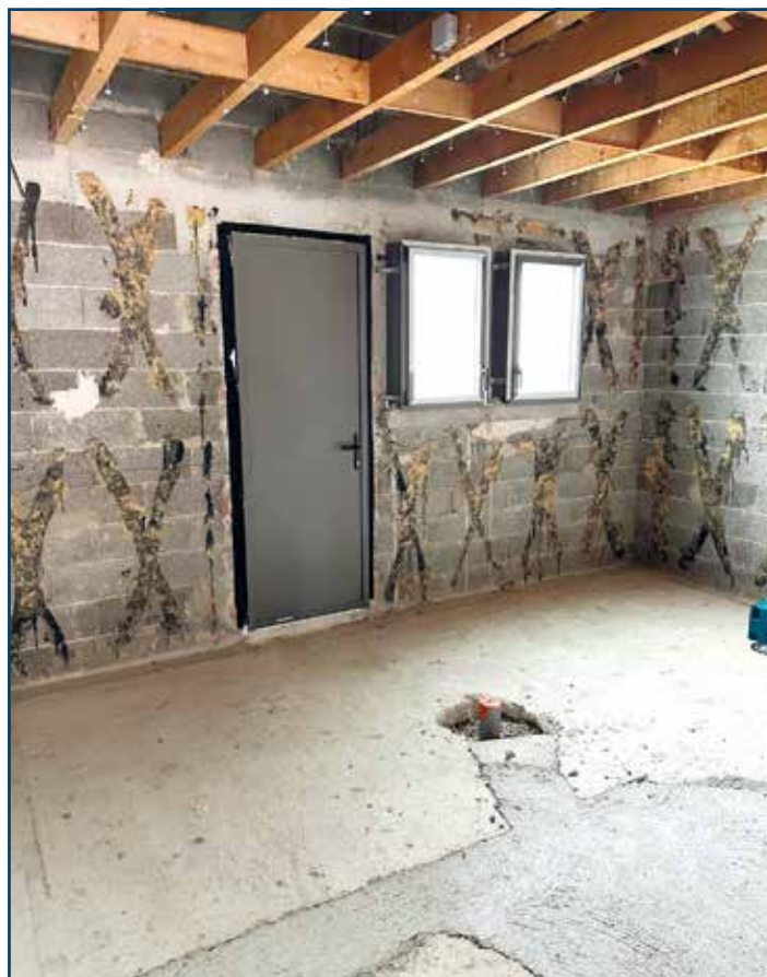
Chantier rénovation/extension vestiaires foot
